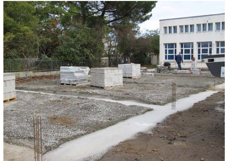
Durée des travaux: été 2012 – été 2013
